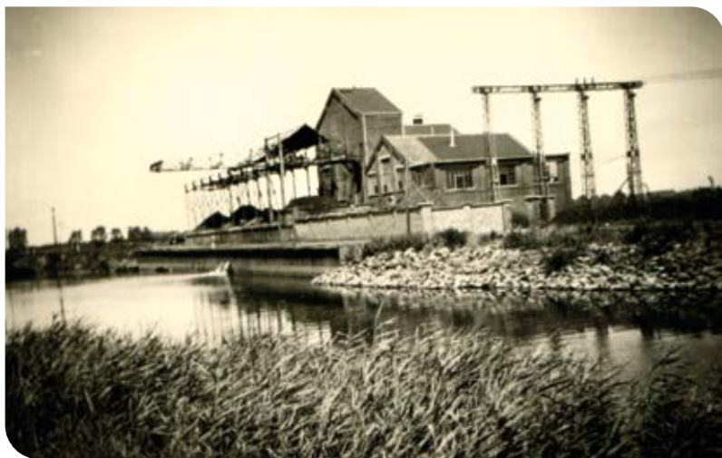
De elektriciteitscentrale in 1952.
